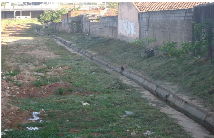
Figura 36 - Lançamentos clandestinos de esgoto – Próximo à Av. Emílio Chechinatto (Ponto R).
