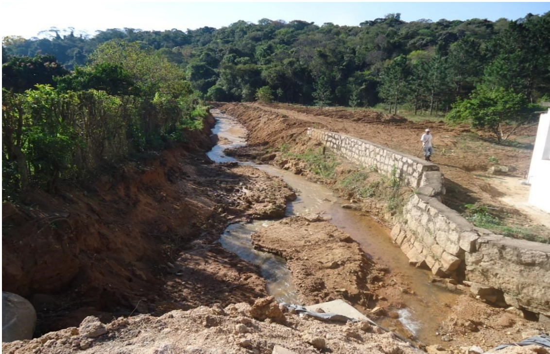
Figura 15 - Guacuri – Obra de alargamento da tubulação (Ponto J)
