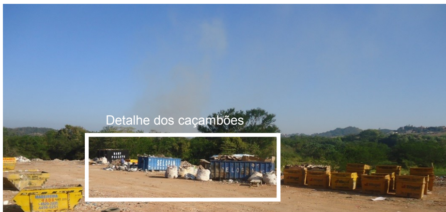
Figura 61 – Área destinada à triagem dos resíduos de construção civil: detalhe dos caçambões.
