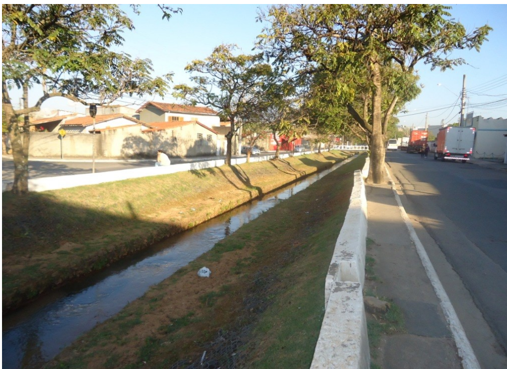
Figura 6 - Ponto de alagamento do Córrego da Lagoa (Ponto A).
