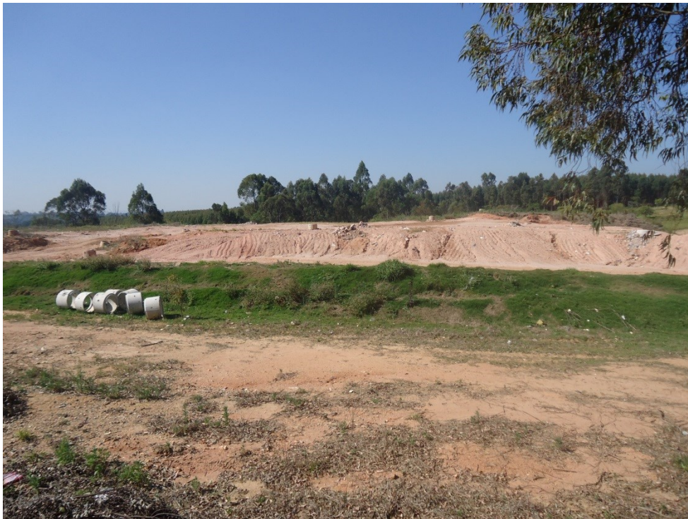
Figura 47 – Vista do Aterro Sanitário Municipal, em Itupeva.
