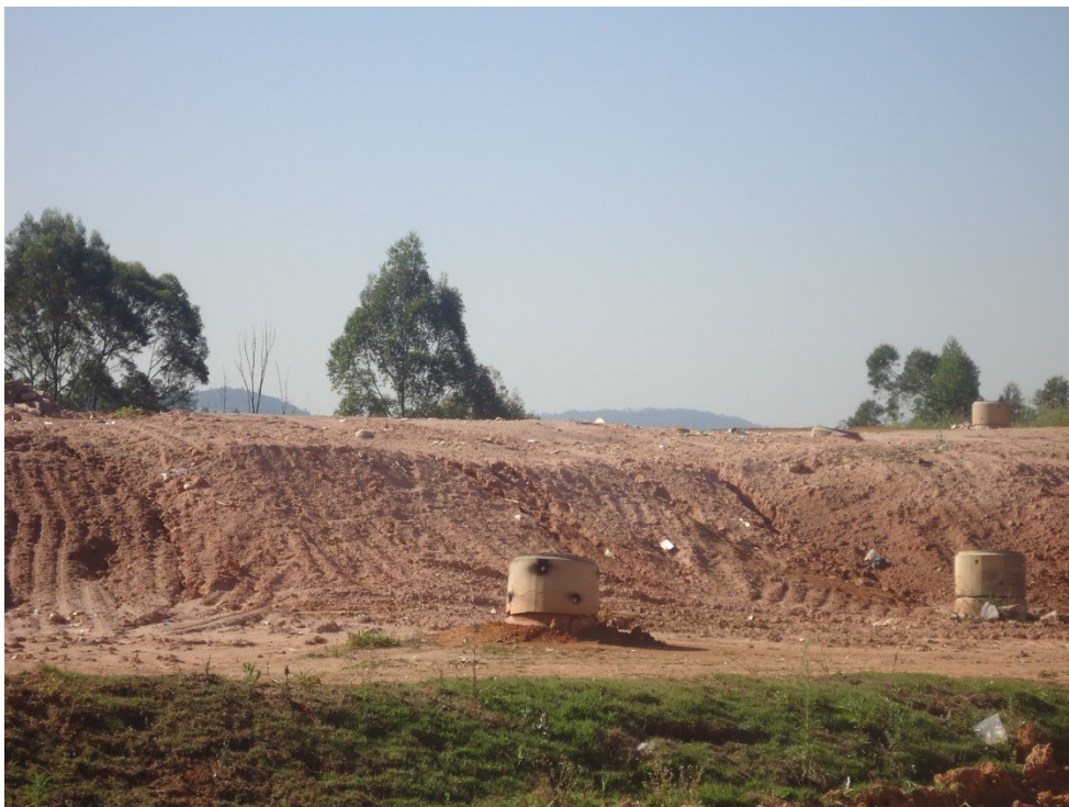
Figura 50 – Queima de gases no Aterro Sanitário Municipal, em Itupeva.
