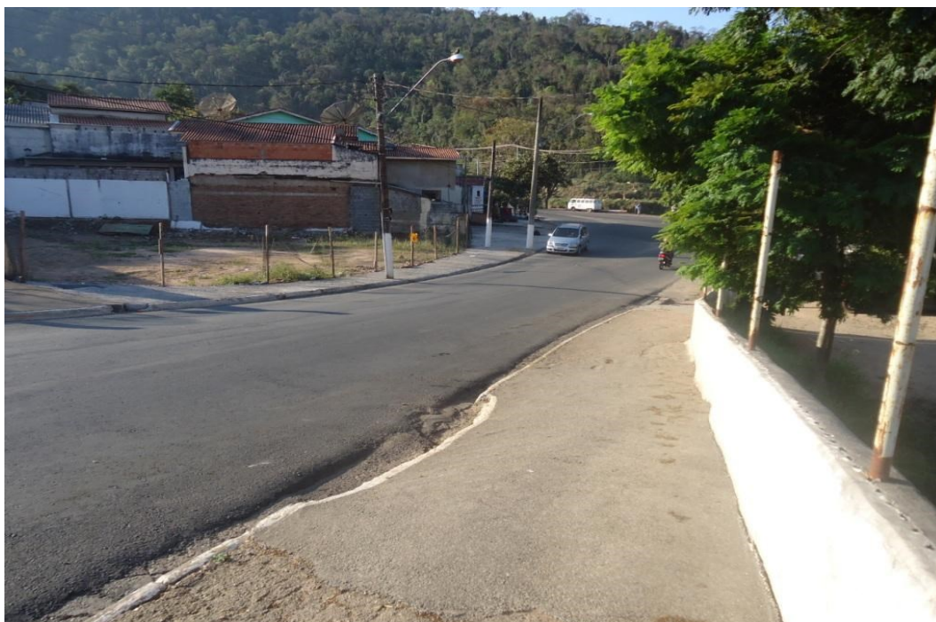
Figura 11 - Ponto alagamento do Córrego do Bonfim canalizado (Ponto F).
