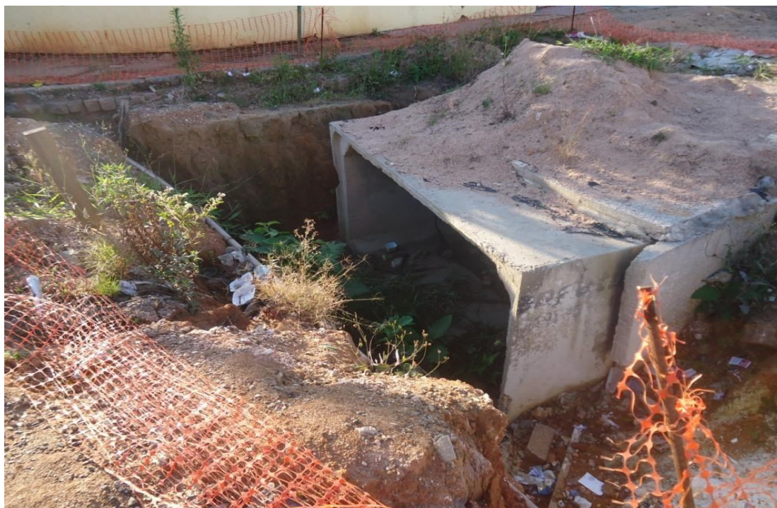
Figura 12 - Obra de alargamento do canal Córrego do Bonfim (Ponto G).
