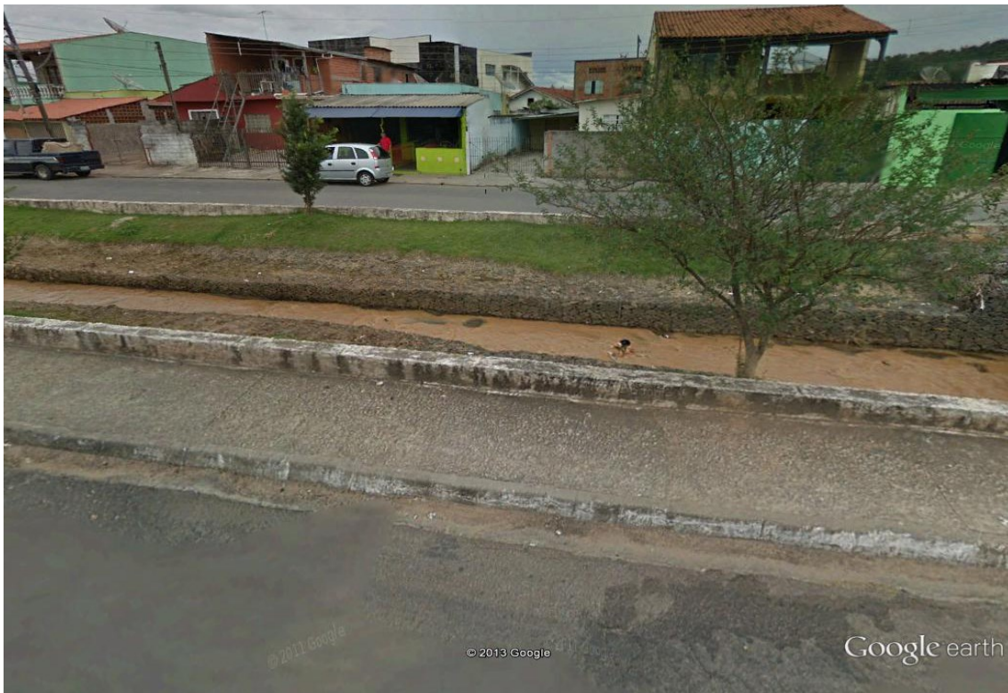
Figura 20 - Assoreamento do Córrego da Lagoa.
